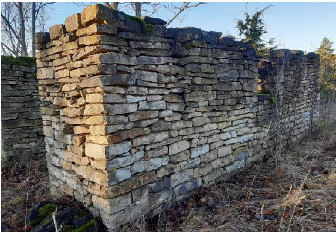
Foto 5.3. Kohalikust kollakashallist dolokivist ehitatud hoone varemed uuringuruumi läänenurgas (foto T. Tuuling, 17.01.2020, N 58°37'32" ja E 24°01'02").
